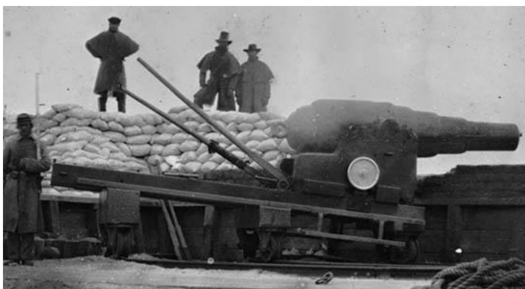
El cañón Armstrong inglés de 8 pulgadas pesaba cerca de 9 toneladas. Fue uno de los primeros cañones pesados de retrocarga y con ánima rayada, y estaba construido a partir de un tubo central rodeado con sucesivos zunchos.
